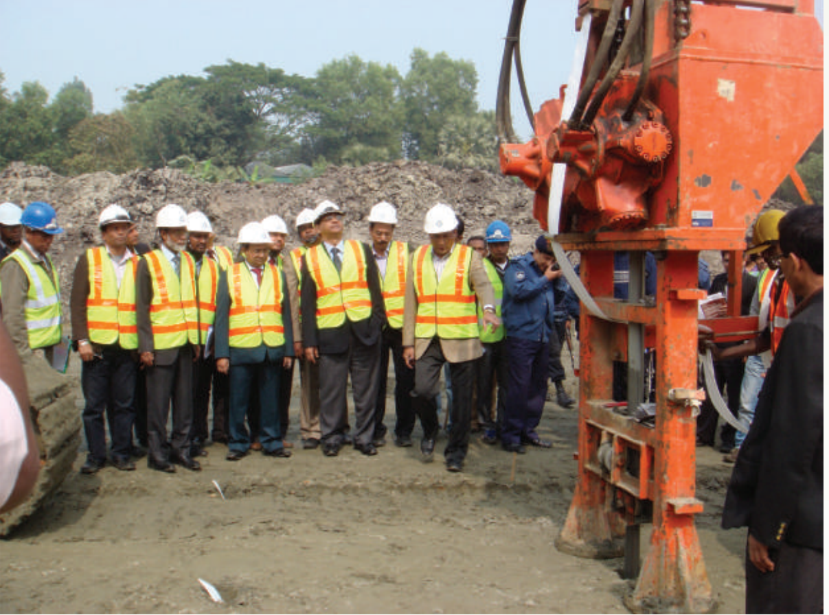
মাননীয় রেলপথ মন্ত্রী কর্তৃক টঙ্গী-ভৈরব বাজার ডাবল লাইন নির্মাণ কাজ পরিদর্শন (৪ ফেব্রুয়ারি ২০১৪)
