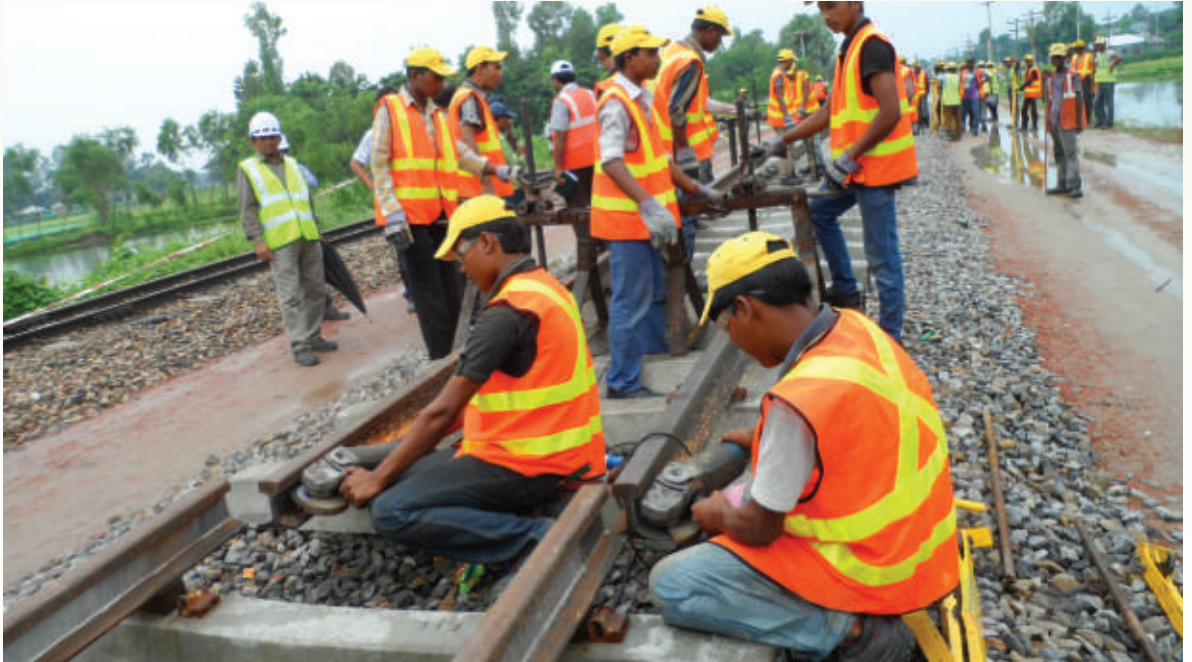
লাকসাম-চিন্কা আস্তানা সেকশনে ডাবল লাইন নির্মাণ প্রকল্পের কাজ
